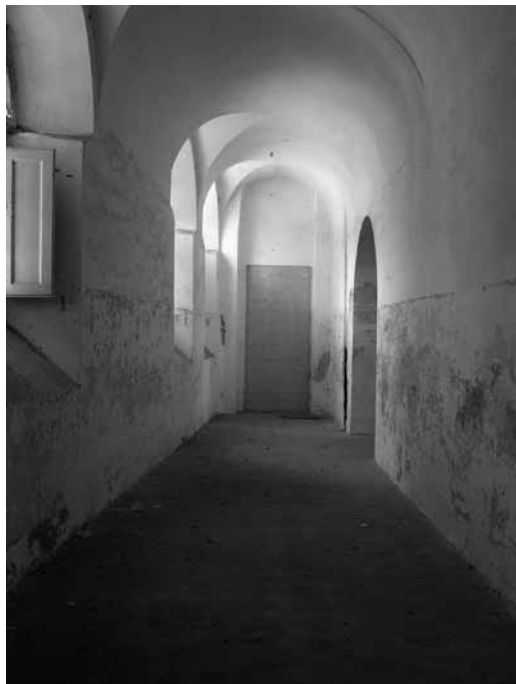
Zazidana vrata, psihiatrična ustanova Pesaro
